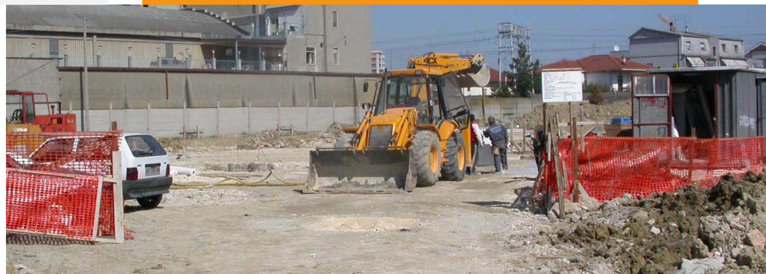
I lavori di costruzione del nuovo magazzino
